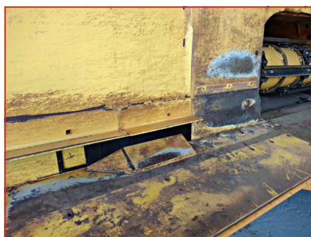
Gabarito para demarcar a janela de passagem das mangueiras do motor hidráulico do módulo central
